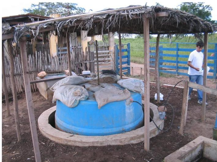
Biodigestor: em destaque a campânula móvel azul
