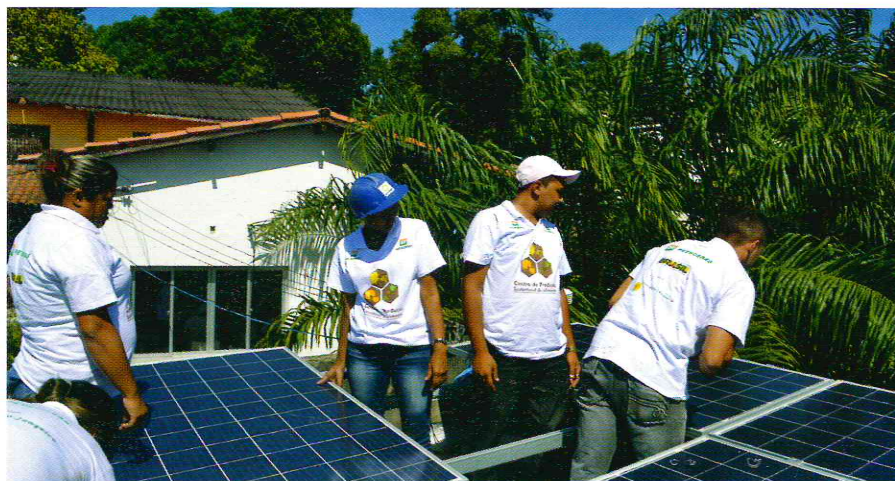
A ação resultou na instalação de seis placas fotovoltaicas de 260W
